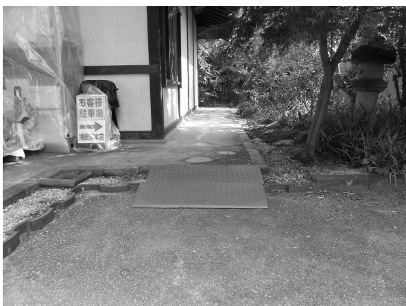
タイヤ止めで段差解消
