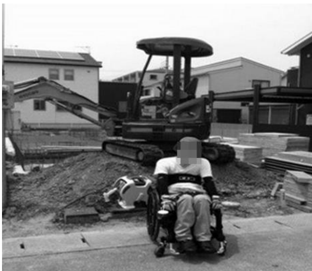
「着工開始・更地にしています。」
