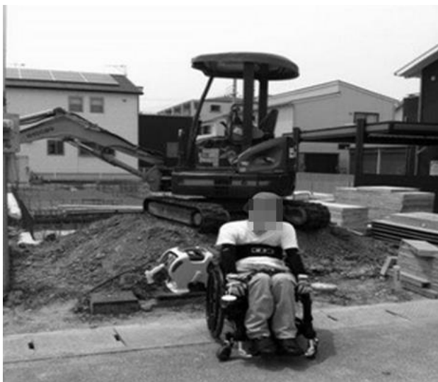
「着工開始・更地にしています。」
