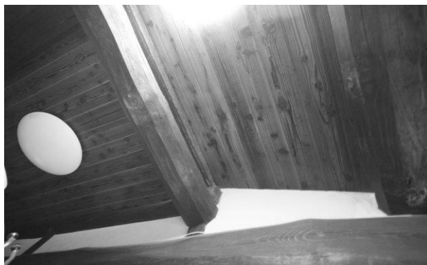
ブラックペッパーが落ちてきた天井
