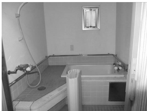
改修前の浴室
