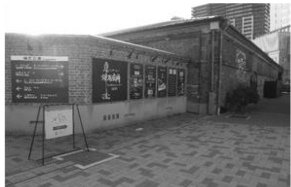
煉瓦倉庫の外観
