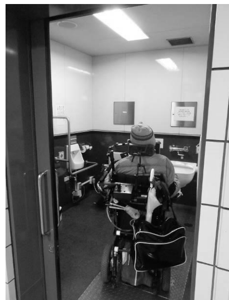
阪神元町駅 多目的トイレ 入り口幅 90 センチ
