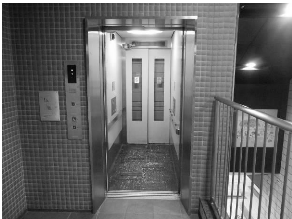
阪神元町駅 地上 EV 幅 90 センチ
