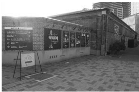
煉瓦倉庫の外観
