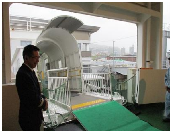
傾斜が15度程ある大分港の人道橋
