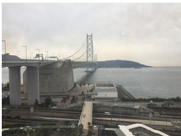
明石海峡大橋
