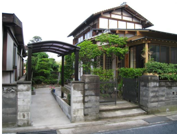
スロープの住宅改修
