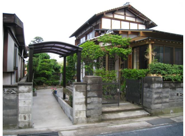
スロープの住宅改修
