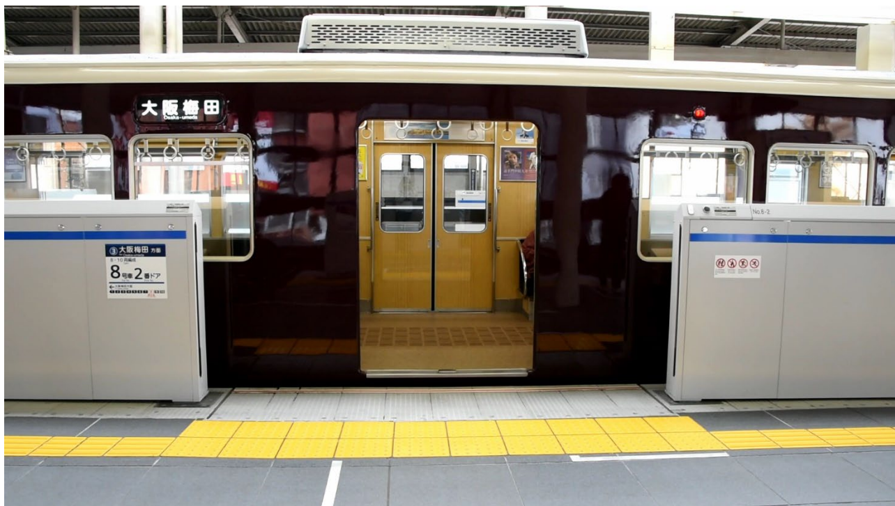
↑ ホームドアは設置してあるが段差解消はされていない阪急電車の駅
