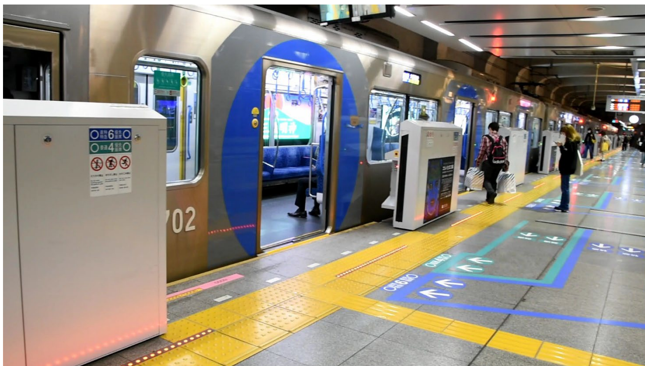
↑ ホームドア設置と段差解消がされた阪神電車の駅
