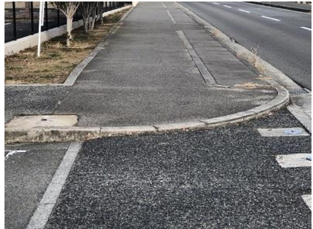
消防署周辺歩道（段差 3 cm）
