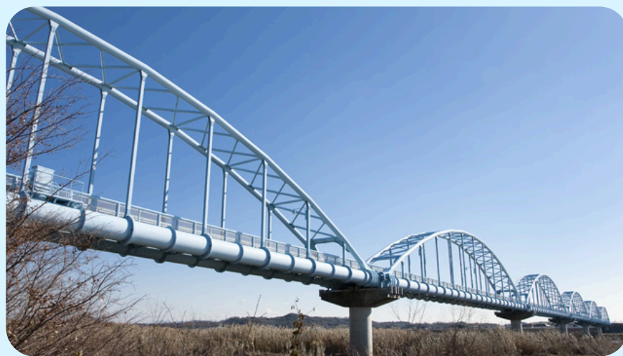
加古川水管橋
